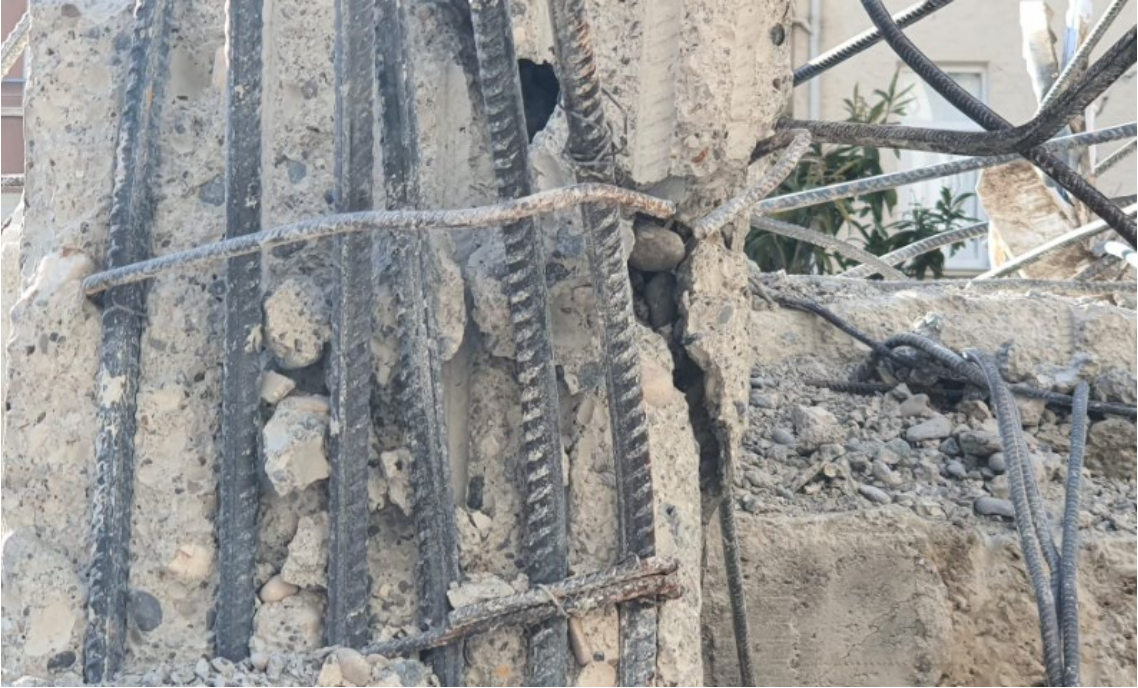
Şekil 29. Etriyelerin uygun olmaması, kancalamanın yetersiz olması
