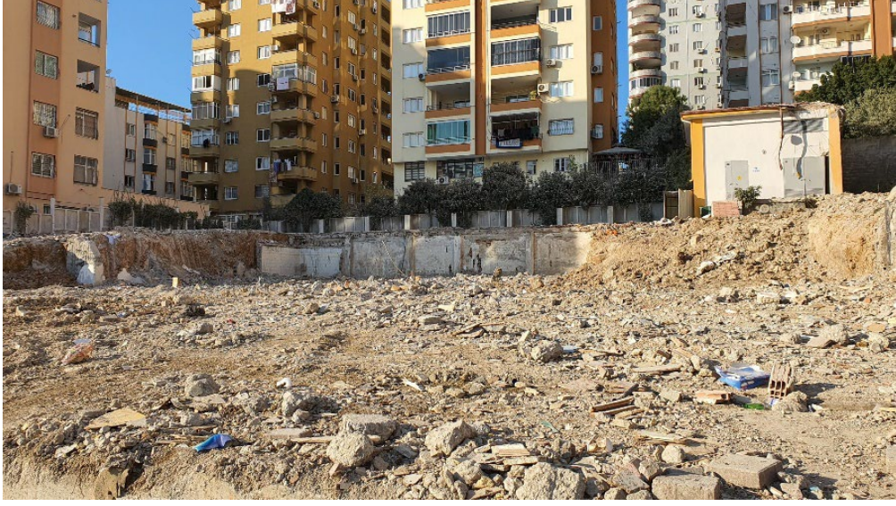
Şekil 26. Yıkılan binanın enkazdan sonraki genel görünümü, Kubilay Apt.
