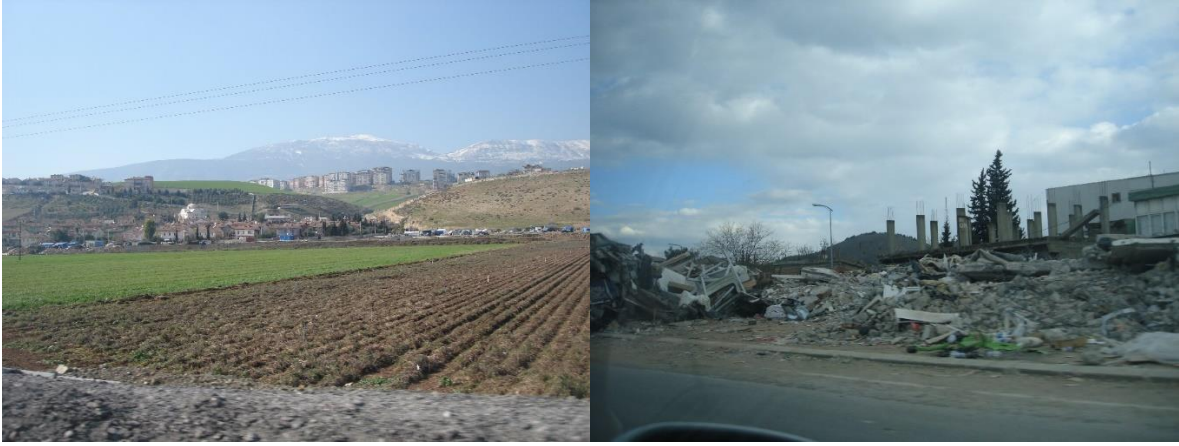
Şekil 41. İslahiye (Gaziantep) ilçesinde yıkımların özellikle alüvyon zemin üzerinde meydana gelmiştir.
