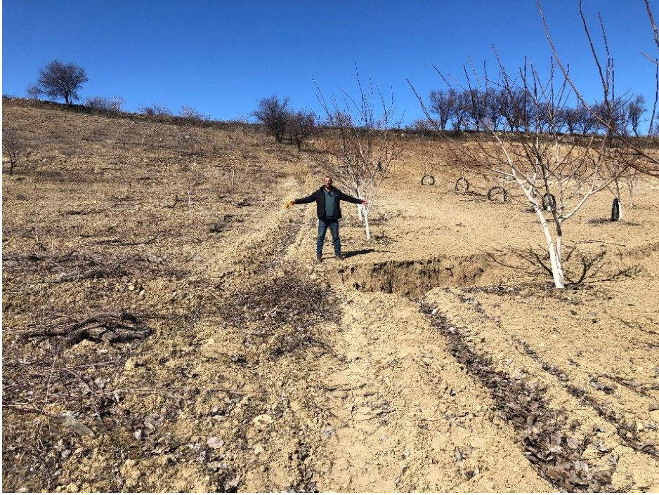
Şekil 44. Balkar-Gölbaşı arası yaklaşık 3 metrelik sol yanal ötelenmenin geliştiği deformasyon.
