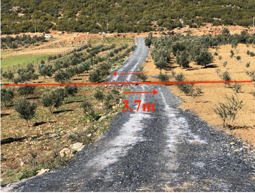
Şekil 42. Nurdağı civarında yüzey kırığı üzerinde oluşan 3,7 m'lik atım.
