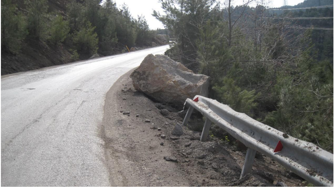
Şekil 50. Başpınar Yaylası Yolu (Aladağ-Adana) üzerinde İnniklik Tepe'den depremler sonrası yamaç aşağı düşen bloklar.
