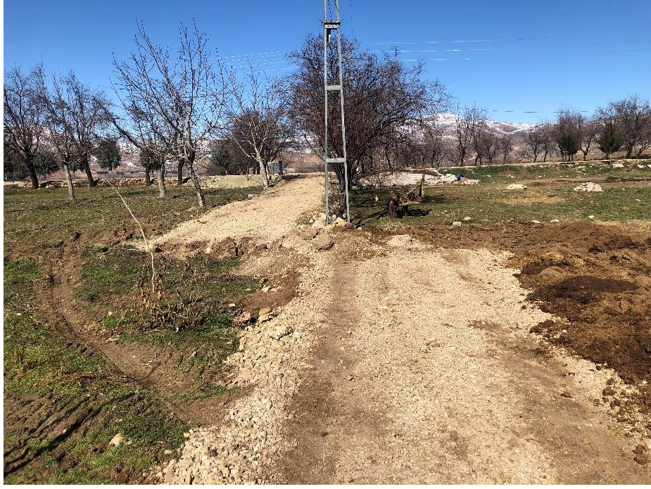
Şekil 45. Balkar-Gölbaşı arası yaklaşık 3,5 metrelik sol yanal ötelenmenin geliştiği deformasyon.
