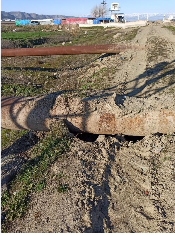
Şekil 37. Beyoğlu, Yeni Mahalle civarında (Kahramanmaraş) DAF zonu üzerinde yaklaşık Dere kenarında yolun bentleşmesi (Su borusu bükülmüş) ve hemen yolun yan tarafında da meydana gelen 77 cm lik kırık oluşumu.
