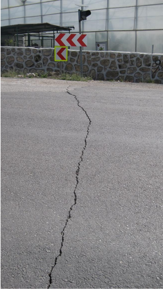
Şekil 55 a-b: Adalı (Karataş-Adana) mahallesi doğu kesimlerinde Ceyhan Nehri kenarında alüvyon zemin üzerinde gelişen yarılmalar yakın alanda karayolu üzerinde de kırılmalar oluşturmuştur.
