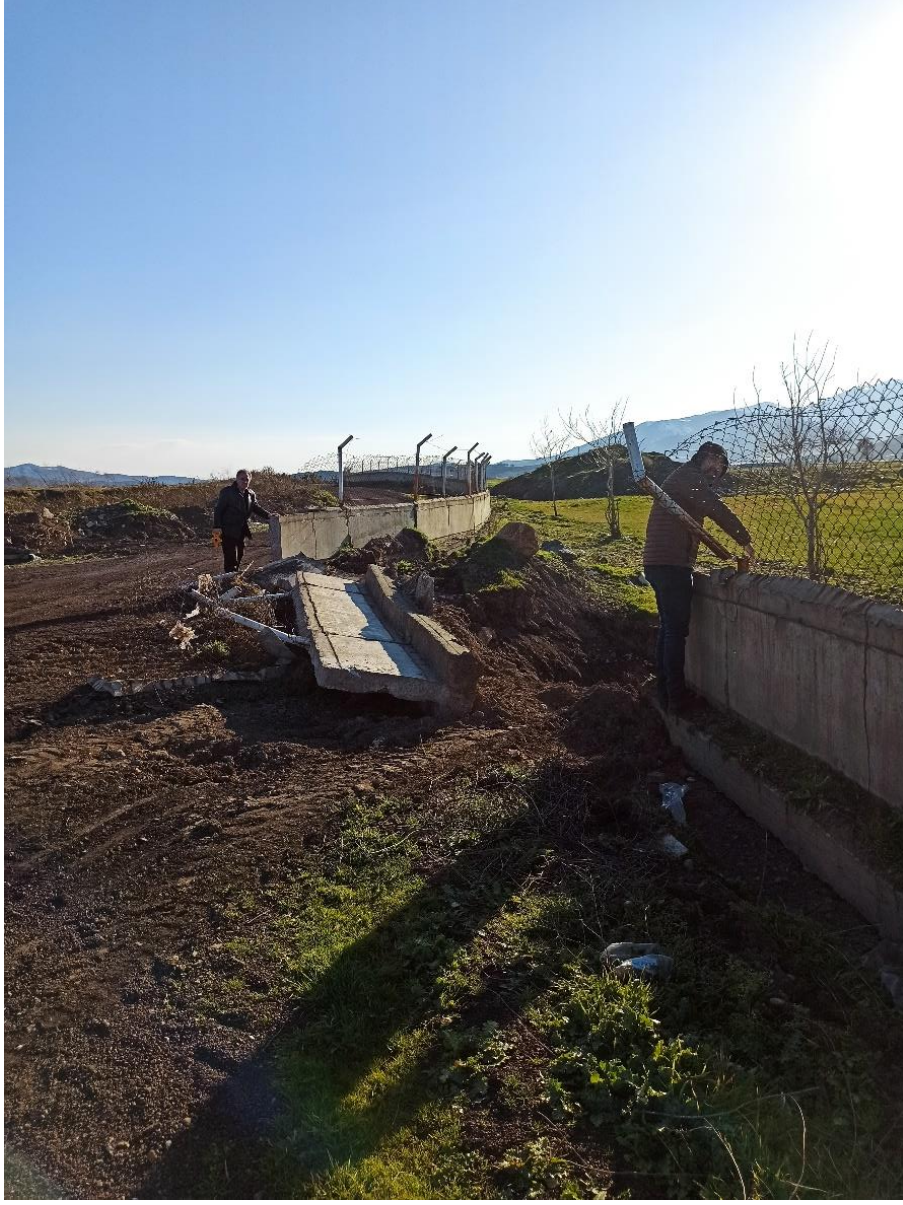
Şekil 32. Beyoğlu, Yeni Mahalle civarında (Kahramanmaraş) DAF zonu üzerinde çit-duvar üzerinde 3.30 metrelik sol yanal atamın gerçekleştirildiği alan.
