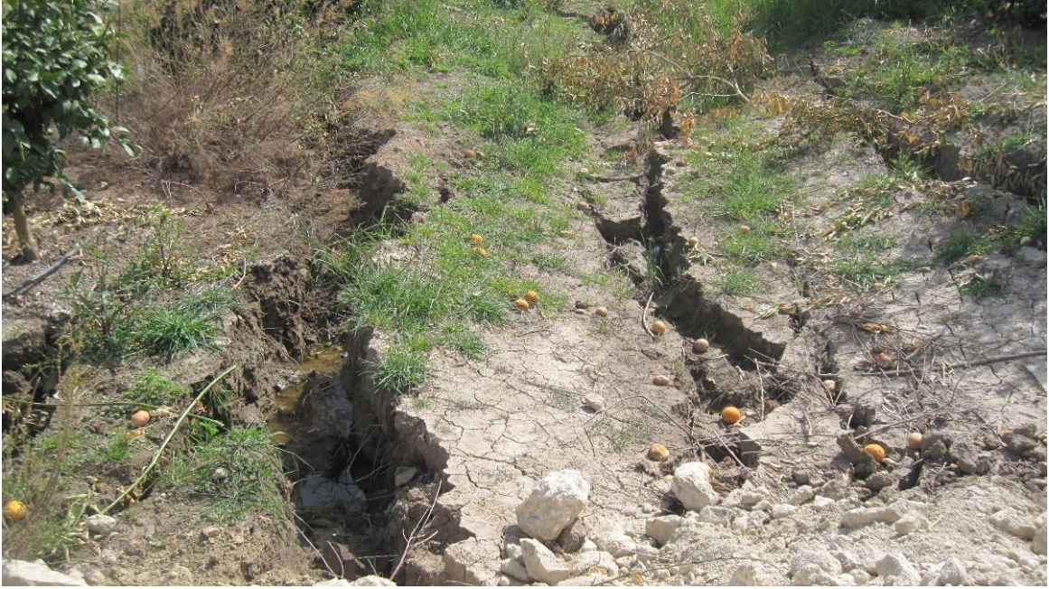
Şekil 54 a-b: Adalı (Karataş-Adana) mahallesi doğu kesimlerinde Ceyhan Nehri kenarında alüvyon zemin üzerinde Narenciye bahçesi üzerinde Ceyhan Nehrinin akış yönüne paralel şekilde (K25B yönlü) gelişen yarılmalar
