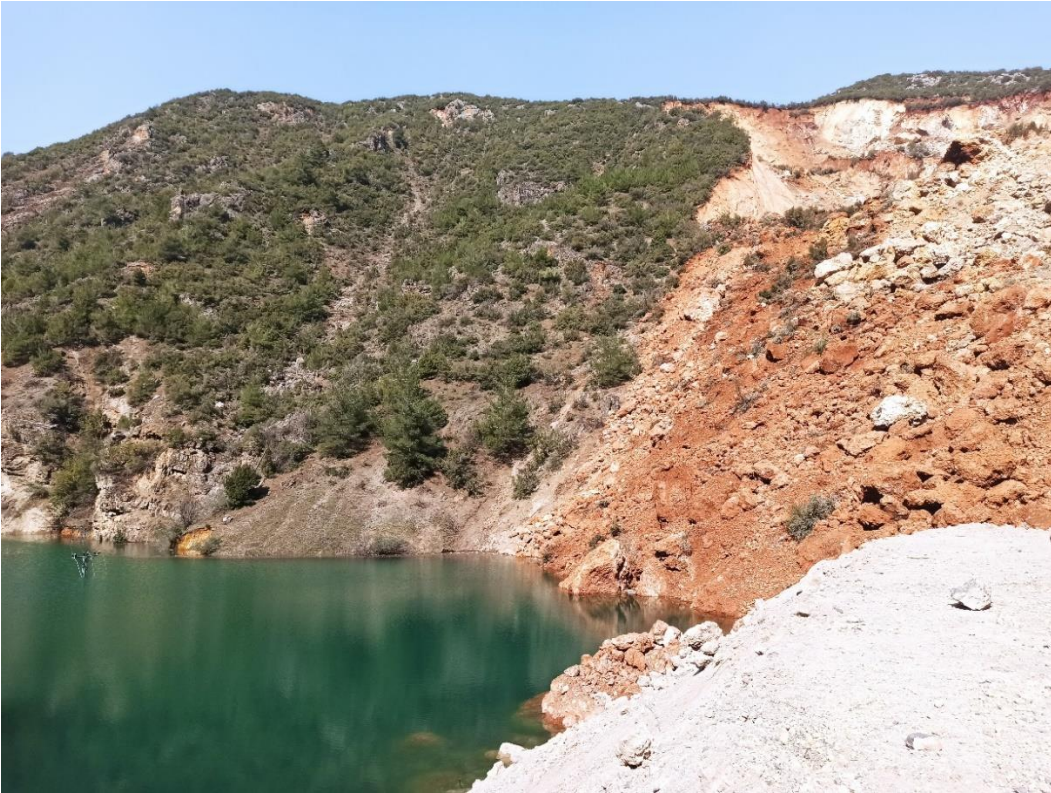
Şekil 43. Islahiye İdilli arasında deprem nedeni ile meydana gelen heyelan ve dere yatağının kapanması sonucu oluşan gölet.
