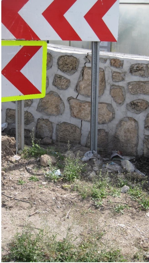
Şekil 55 a-b: Adalı (Karataş-Adana) mahallesi doğu kesimlerinde Ceyhan Nehri kenarında alüvyon zemin üzerinde gelişen yarılmalar yakın alanda karayolu üzerinde de kırılmalar oluşturmuştur.
