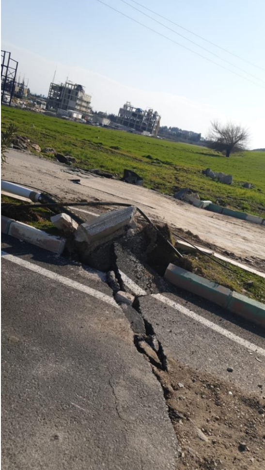
Şekil 28. Beyazıdi Bestami Türbesi karayolu üzerinde (Kırıkhan/Hatay) 45 cm sol yanıl doğrultu atımın oluřtuđu alan.
