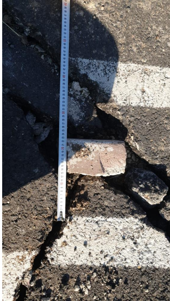
Şekil 28. Beyazıdi Bestami Türbesi karayolu üzerinde (Kırıkhan/Hatay) 45 cm sol yanıl doğrultu atımın oluřtuđu alan.
